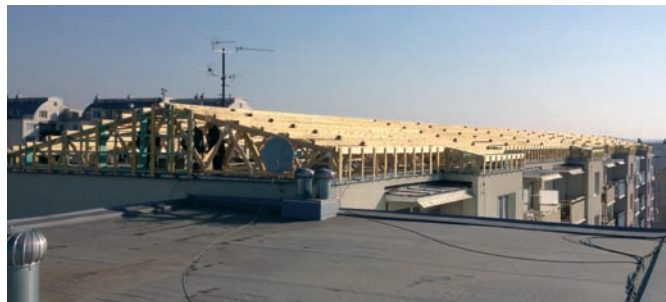
Foto realizace střechy
